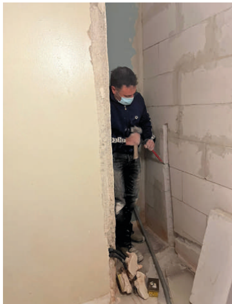
Ristrutturazione in corso a Casa Ail La Coccinella
